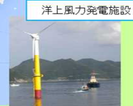
洋上風力発電施設
