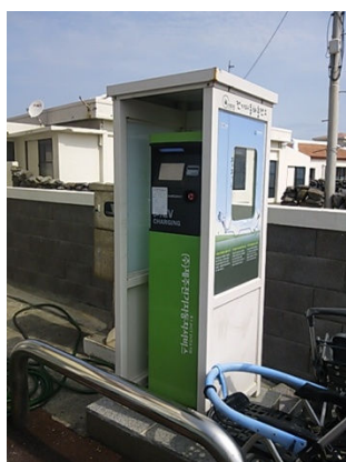
EV用充電スタンド
