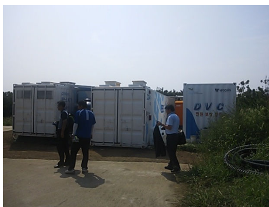
発電所敷地内に設置された定置型蓄電池
